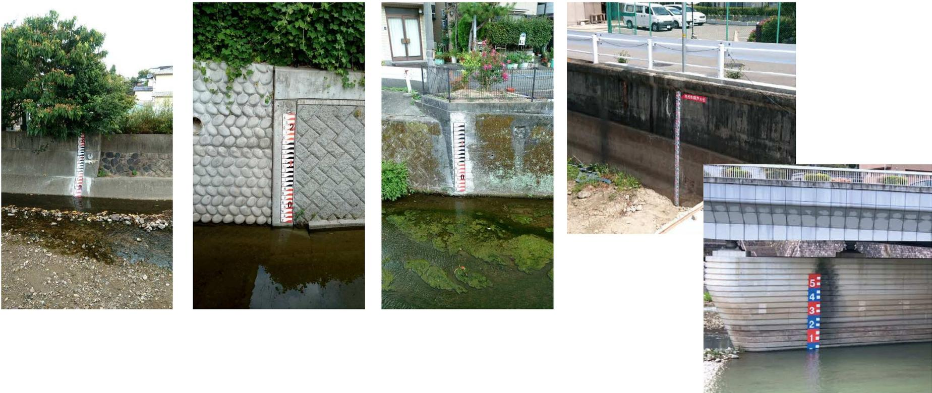
防災スイッチに水位確認板(量水標)を設置
